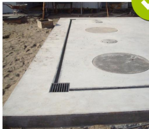
Piso impermeável em concreto com canaletas.
