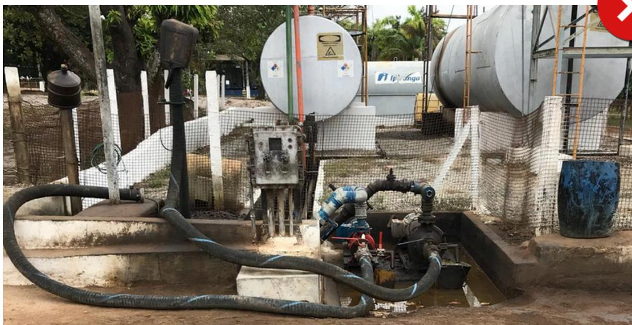
Instalação sem piso impermeável, gerando risco de contaminação.
