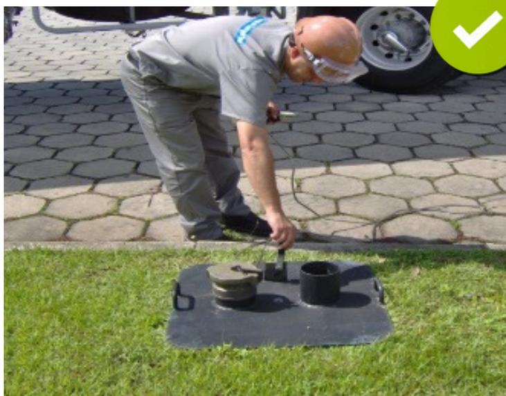
Conexão entre ponto de aterramento e caminhão tanque
