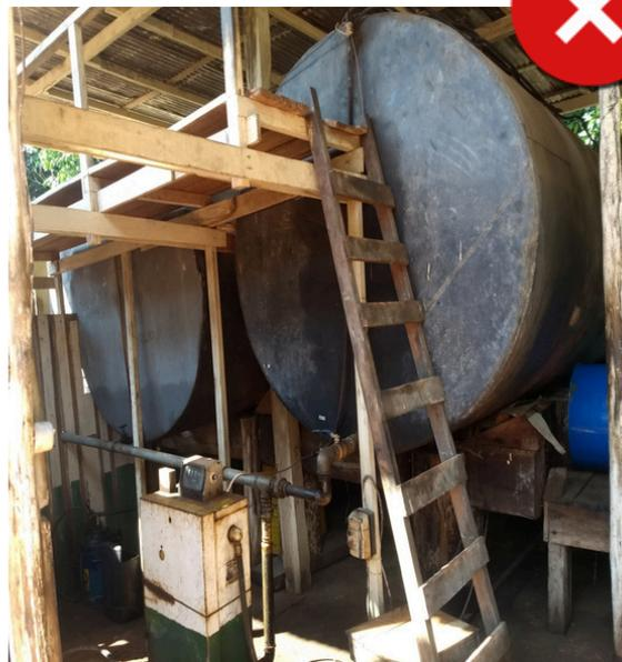
Tanque aéreo com identificação visual de vazamento.
