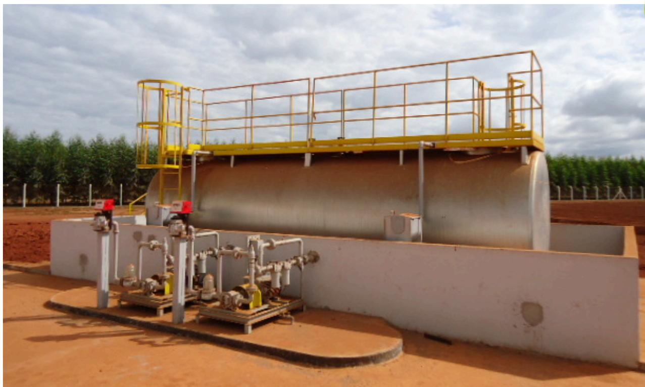
Exemplo de conjunto de instalação com skid de abastecimento e tanque aéreo com bacia de contenção em alvenaria
