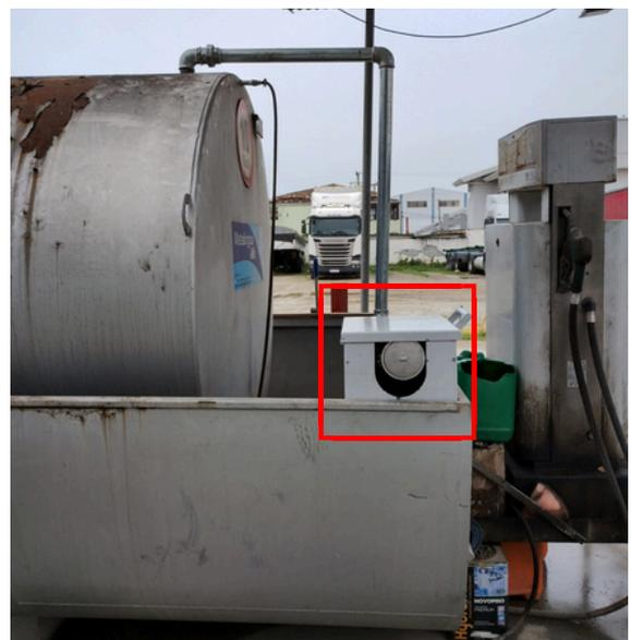
Exemplo de tanque antes e depois da instalação do bocal de descarga selada
