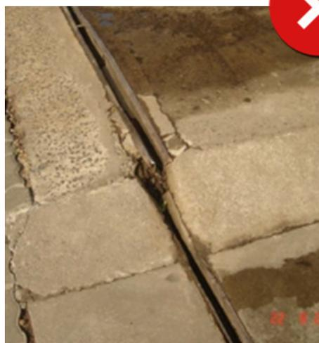
Ausência de piso impermeável em concreto com canaletas (direcionamento para CSAO).
